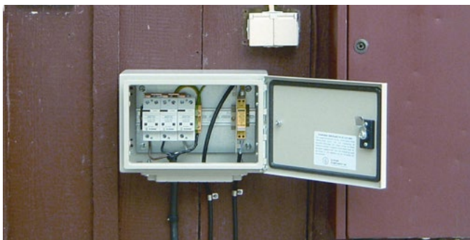
Exempel på inledningsskydd för el och tele.
