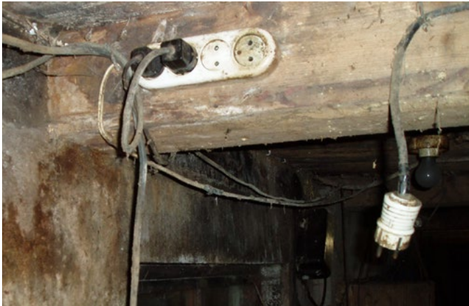
Gummikablar får aldrig ersätta den fasta installationen. Gummikablar får endast användas för tillfälliga anslutningar av flyttbara maskiner och apparater. Läs mer om detta i kapitel 4 El och åska.
